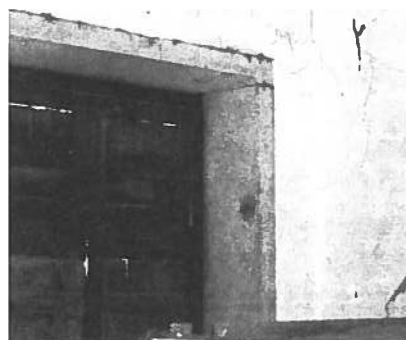
Fig. 20 Pormenor da parede exterior do topo Poente, vista do seu intradorso. É visível a aplicação de alvenaria de tijolos conjuntamente com alvenaria de pedra. Fonte: Arquivo pessoal Luis Corredoura.
