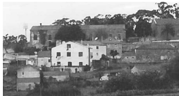
Fig. 25 Vista panorâmica do Palácio dos Marqueses de Ponte de Lima. Distingue-se a diferença de tom do revestimento da cobertura, sendo o da zona da direita aquele que terá sido colocado há menos tempo. Tapado pelas árvores, encontra-se o local da cobertura que colapsou Fonte: Arquivo pessoal Luís Corredoura.
