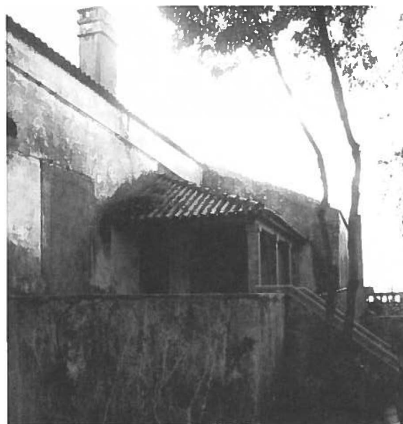
Fig. 11 Entrada principal do edifício, feita a partir do lado Norte. Fonte: Arquivo pessoal Luis Corredoura.
