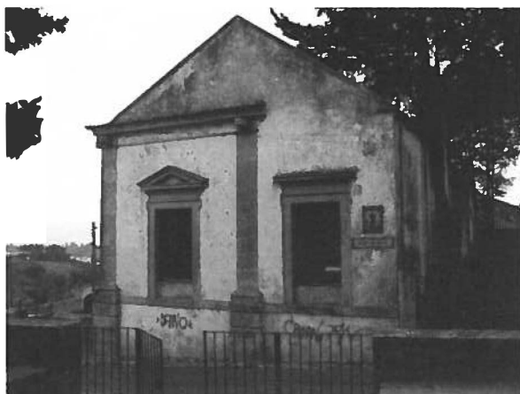
Fig. 9 Fachada Nascente do Palácio dos Marqueses de Ponte de Lima. Fonte: Arquivo pessoal Luis Corredoura.
