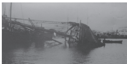
Figura 3 – Embarcação virada de querena, realizando-se a reparação das obras-vivas junto à quilha, na doca de Alcântara em Lisboa. Registo de 1920. Arquivo fotográfico do Museu de Marinha.
