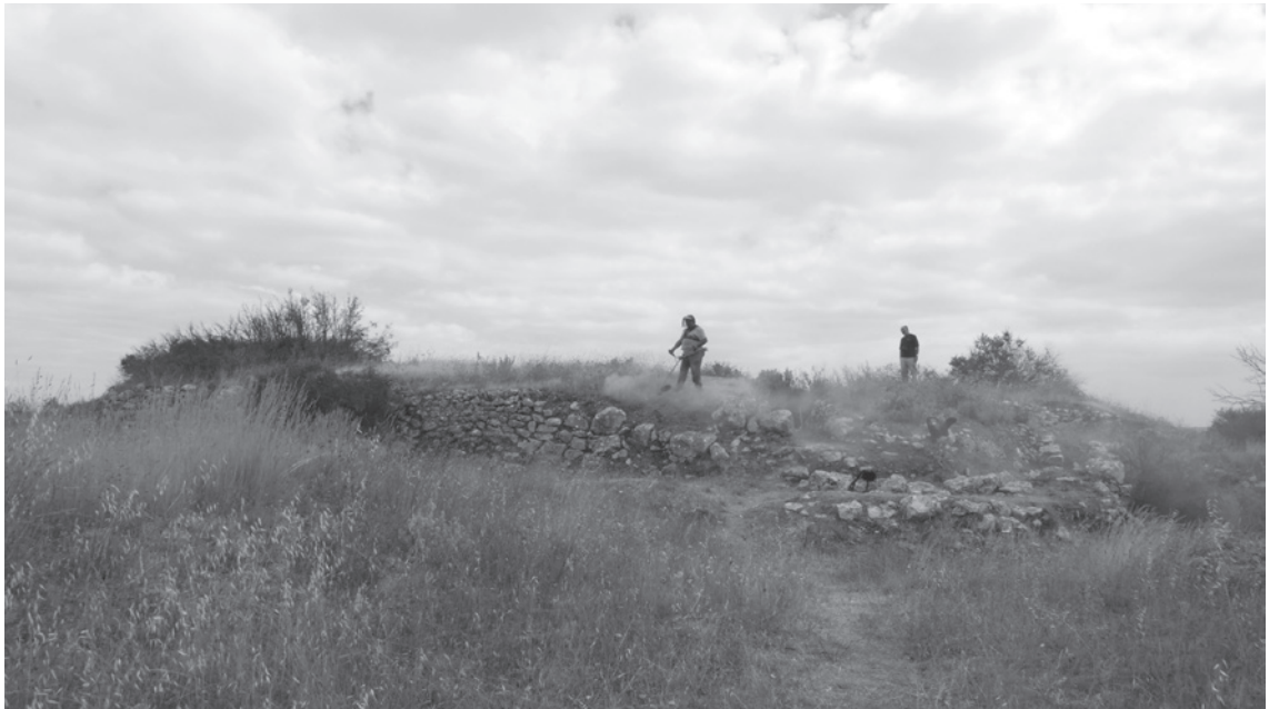
Figura 6 – Trabalhos de desmatação da área do reduto central.
