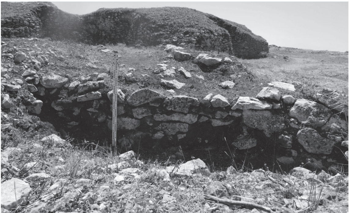
Figura 14 – Face externa da estrutura semi-circular identificada após os trabalhos de limpeza e desmatamento.
