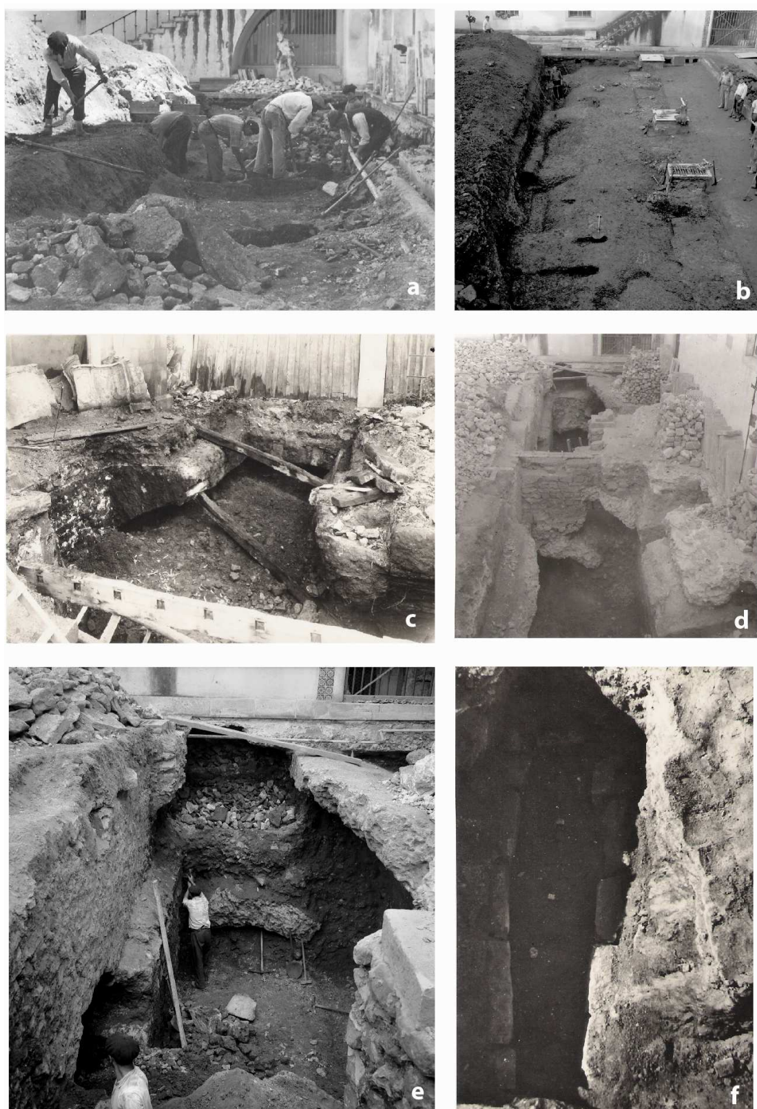
Fig. 12 – a-b: trabalhos de impermeabilização das galerias do piso superior do criptopórtico (1958); c-d: pormenor da derrocada parcial de alguns tramos das galerias; e: trabalhos de escavação da galeria F pela DGEMN (Departamento de Documentação Fotográfica – Instituto dos Museus e da Conservação); f: pormenor de sepultura estruturada nos aterros de colmatação da galeria F (Arquivo MNMC).
