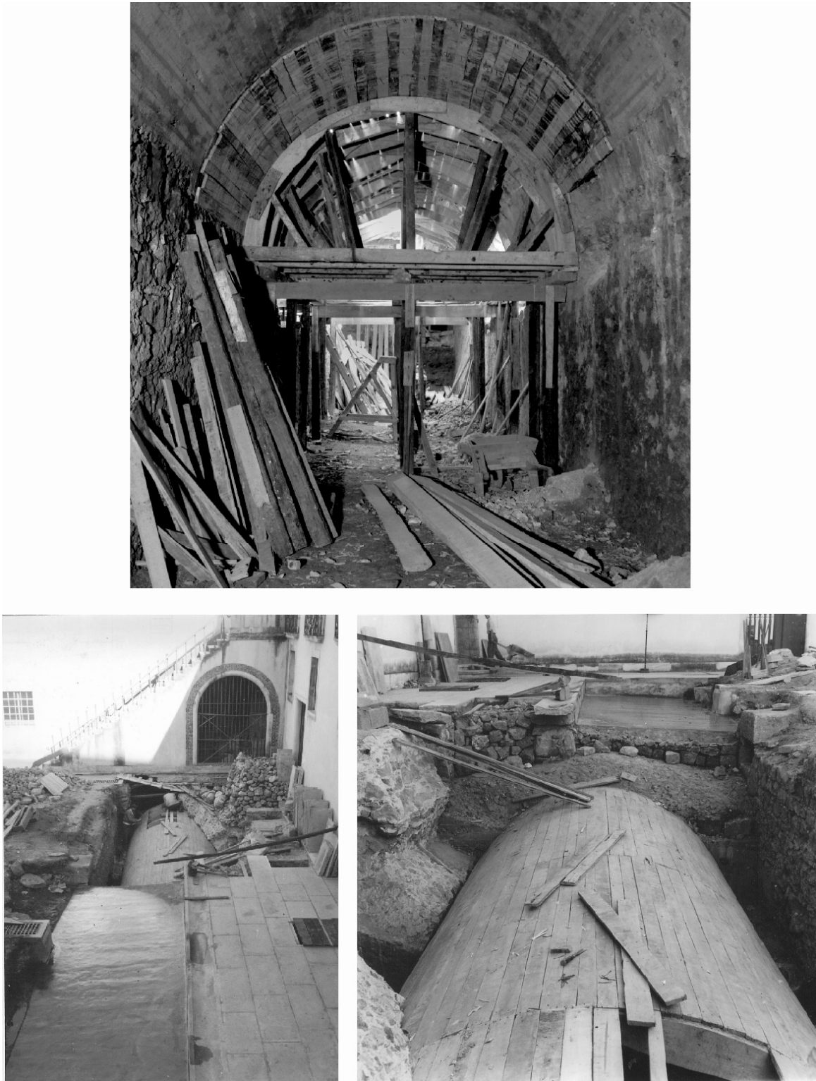
Fig. 13 - Trabalhos de reconstrução da abóbada da galeria F do piso superior do Criptopórtico pela DGEMN (Departamento de Documentação Fotográfica – Instituto dos Museus e da Conservação).
