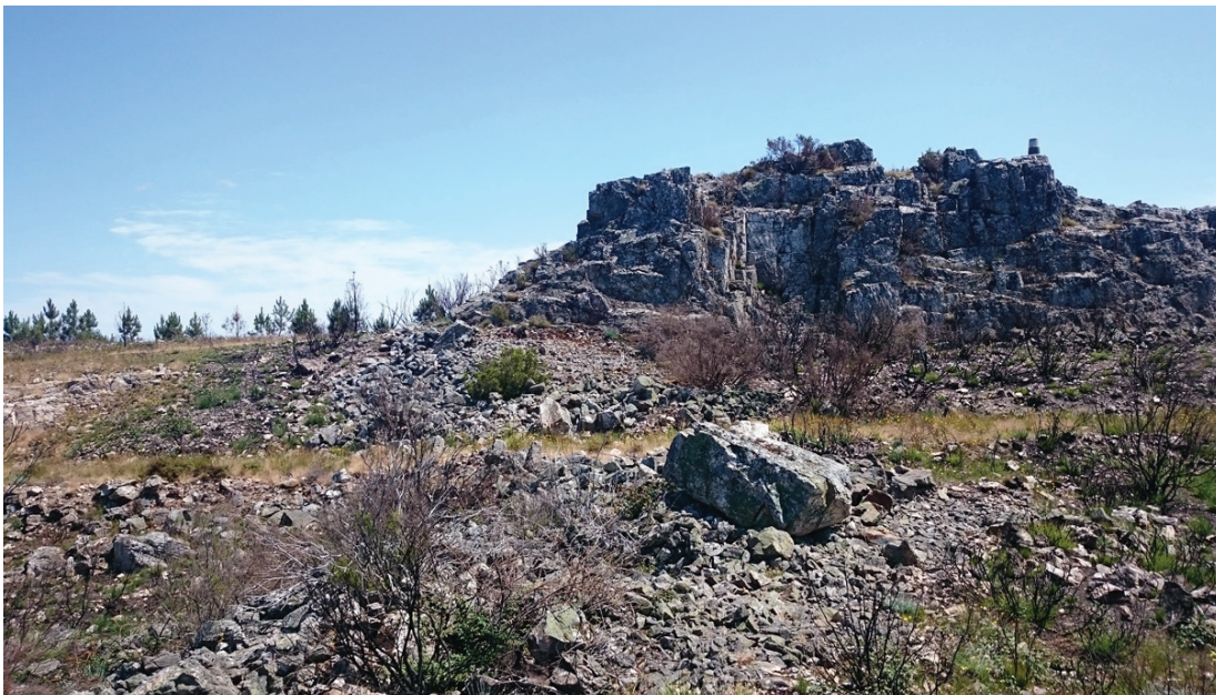
Figura 6 – Aspeto geral da muralha antes da intervenção (sondagem 6).
