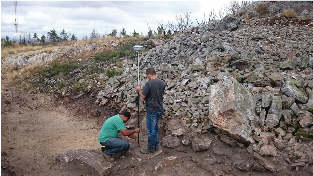
Figura 5 – Registo do corte Oeste da muralha (sondagem 6).
